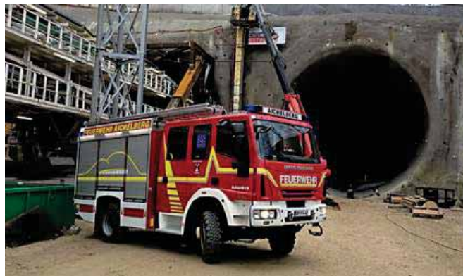
Ein Fahrzeug der Feuerwehr vor der Tunnelbaustelle. Fotos: Feuerwehr Aichelberg
