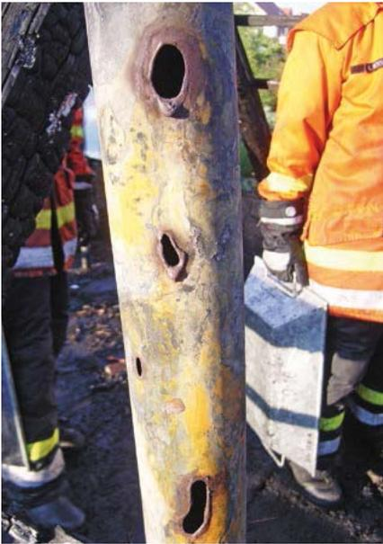
Die hohe Energie eines Blitzes zerstört den Dachständer und verursacht einen Dachstuhlbrand
