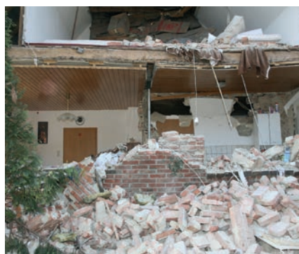
In dem Haus links wurde eine Treibgas- statt einer Flüssiggasflasche an ein Heizgerät angeschlossen. Die Giebelwand rechts ist Spraydosentreibgas zum Opfer gefallen.
