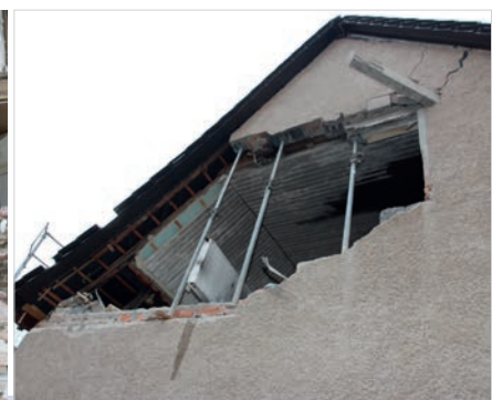
In dem Haus links wurde eine Treibgas- statt einer Flüssiggasflasche an ein Heizgerät angeschlossen. Die Giebelwand rechts ist Spraydosentreibgas zum Opfer gefallen.
