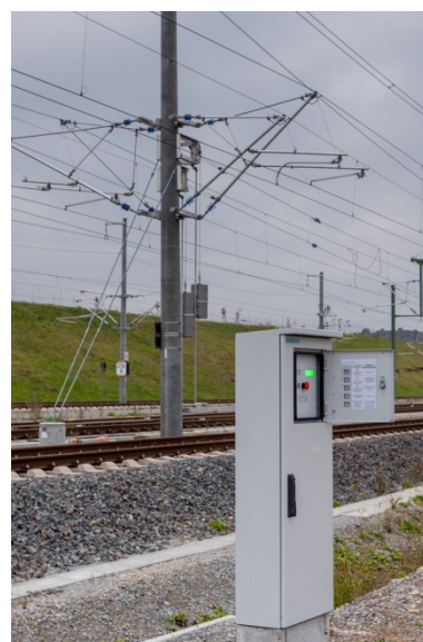
Abbildung 14: Bedienschrank einer OLSP
