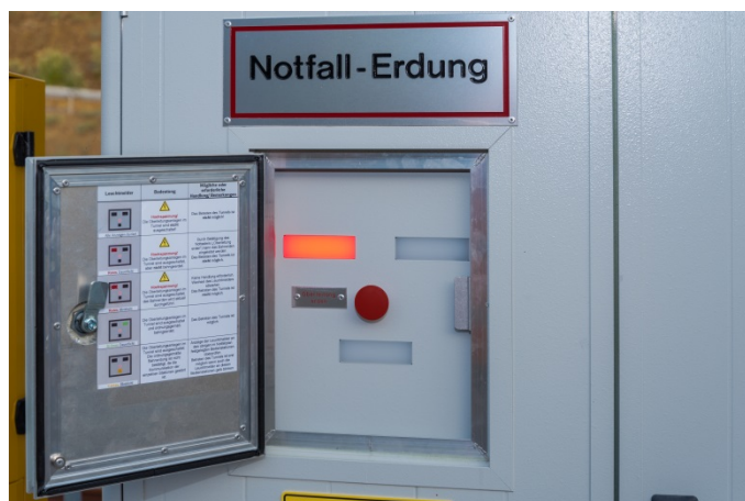
Abbildung 13: Leuchtmelder und Nottaster einer OLSP
