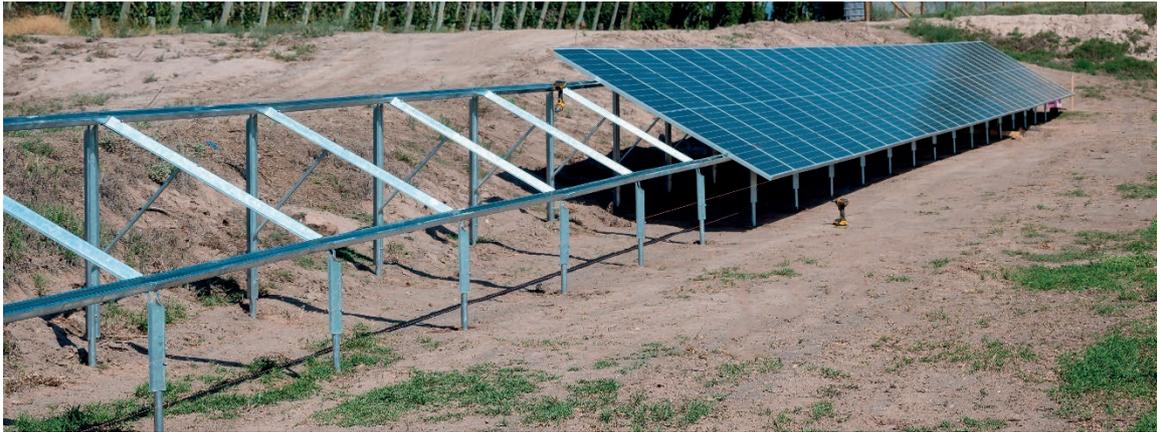
Abbildung 16: Montagevorbereitung für „stehende“ PV-Module (user20014964 - freepik.com)
