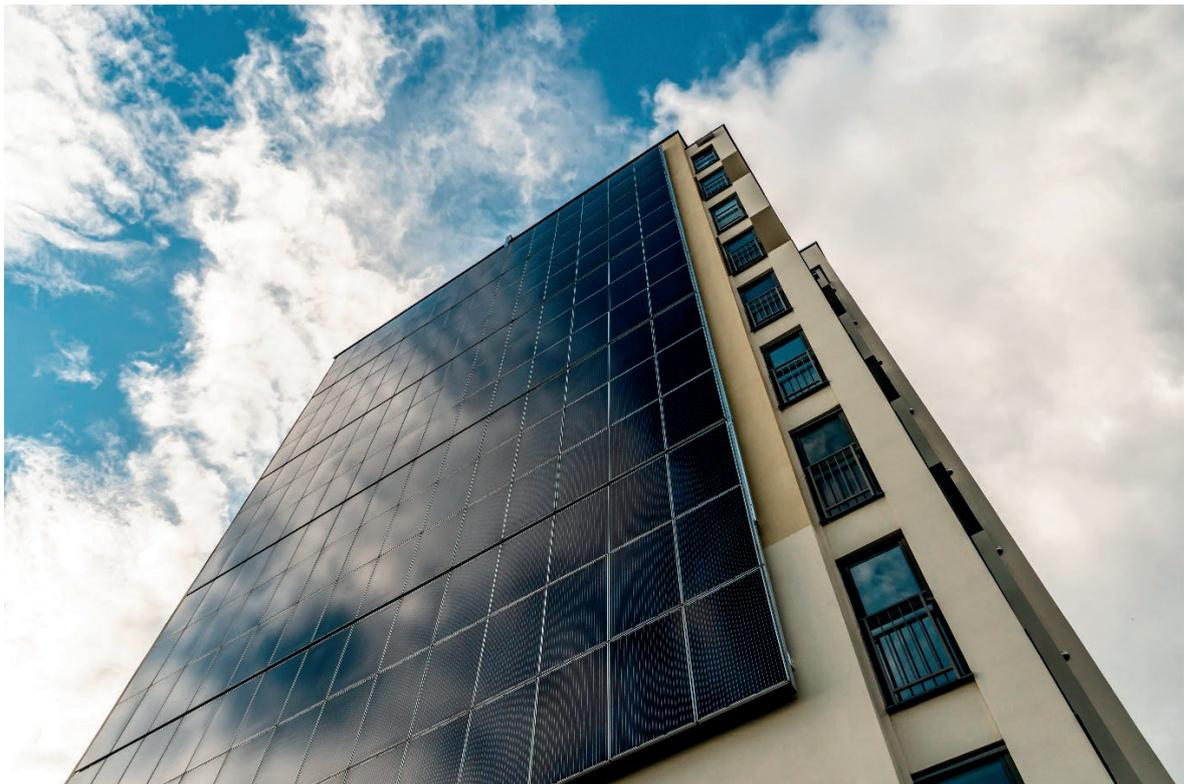
*Abbildung 10: PV-Paneele an Fassaden (Ansario - freepik.com)*
