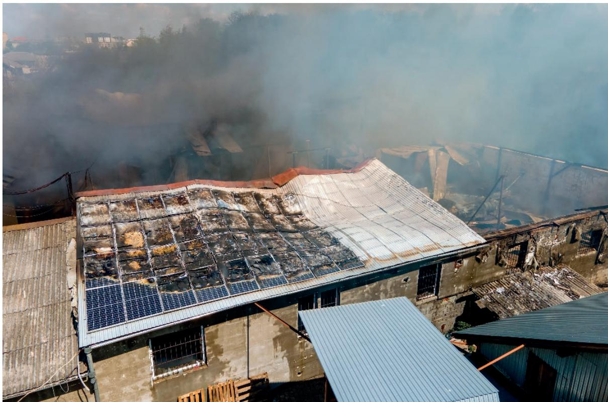
Abbildung 35: Dachstuhlbrand mit PV-Anlage (bilanol - freepik.com)
