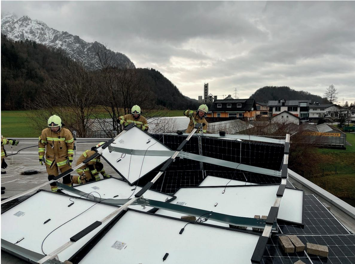
Abbildung 37: PV-Module nach einem Sturm (Josef Tschematschar - Feuerwehr Hallein)
