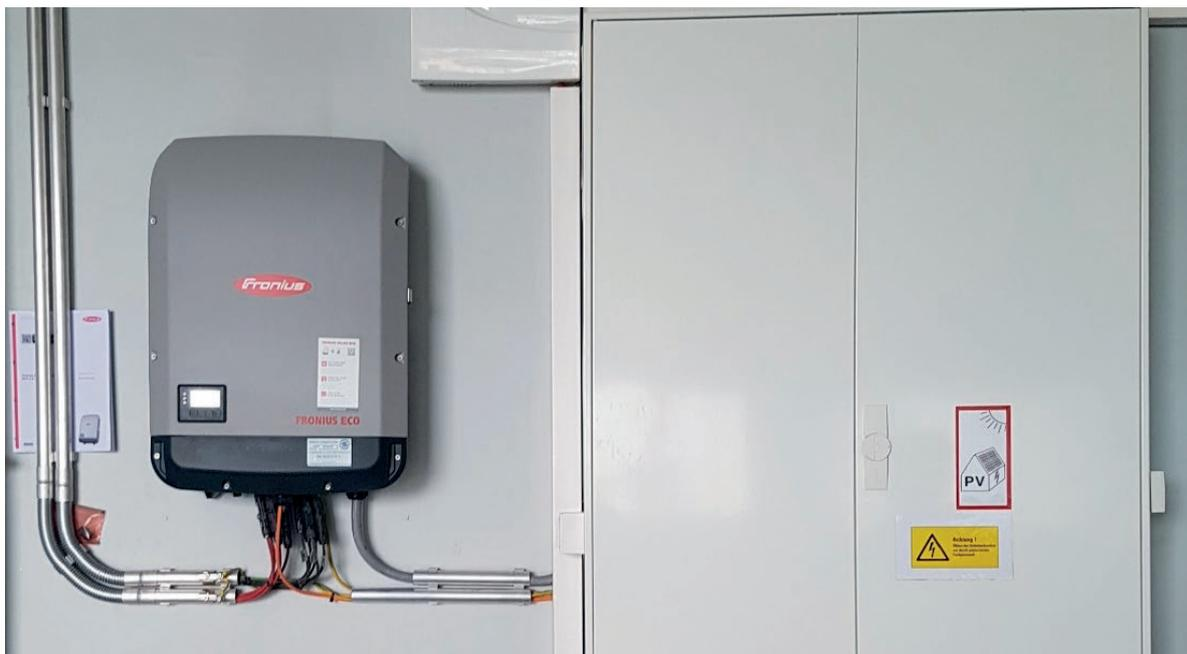
Abbildung 21: Wechselrichter Montageort (Vogler)
